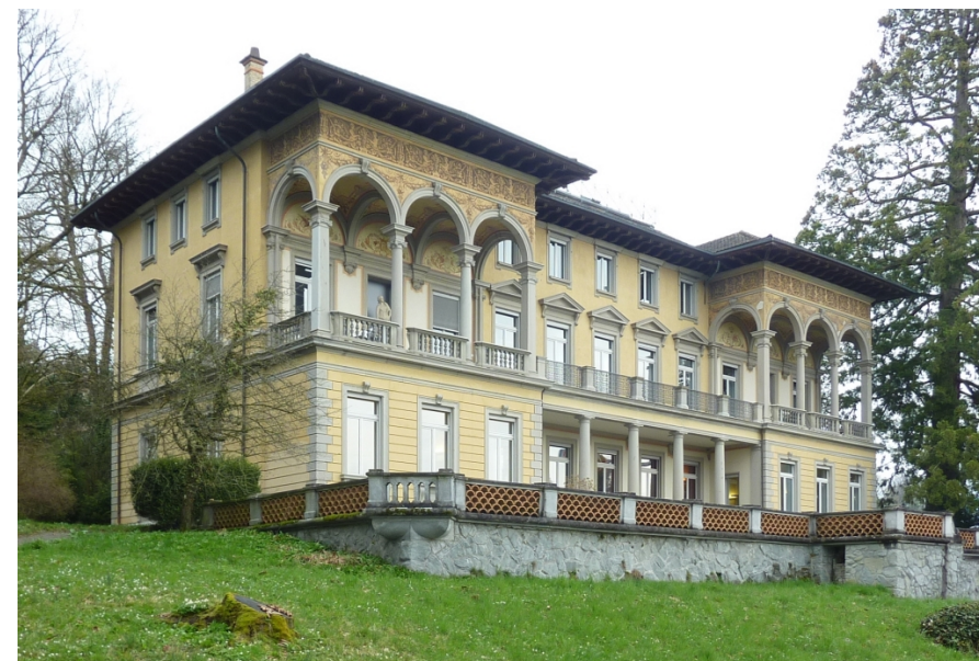
Bellerivestrasse 19, Villa Bellerive, Ansicht von SW (Aufnahme 2017)
